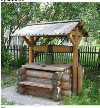
По периметру оголовка шахтного колодца должен быть выполнен «замок» из тщательно уплотненной глины или жирного суглинка глубиной 2 метра и шириной 1 метр, а также отмостка из камня, кирпича, бетона или асфальта шириной от 1 до 2 метров с уклоном 0,1 от колодца в сторону кювета.
